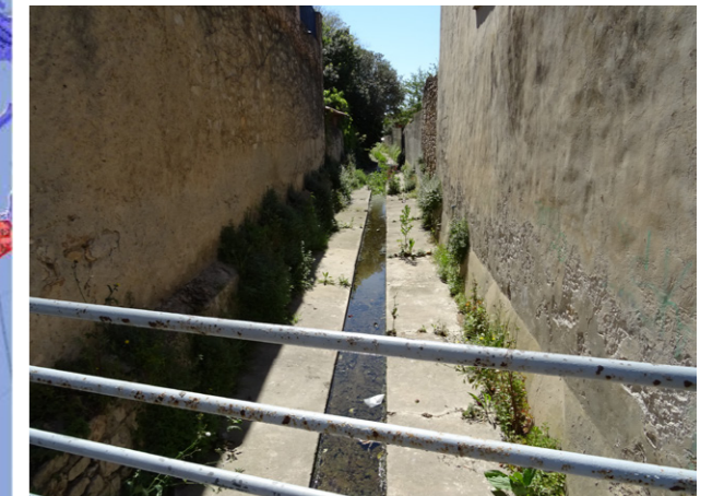
La Capouillère, un ruisseau totalement artificialisé en centre-ville, récupérant les eaux de ruissellement de tout le bassin versant supérieur
