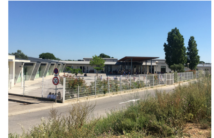
16 Groupe scolaire F. Dolto, cour de récréation
