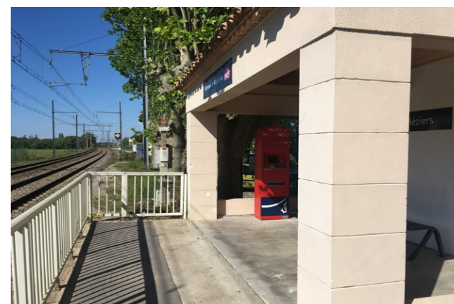
L'abri avec distributeurs de titres de transport
