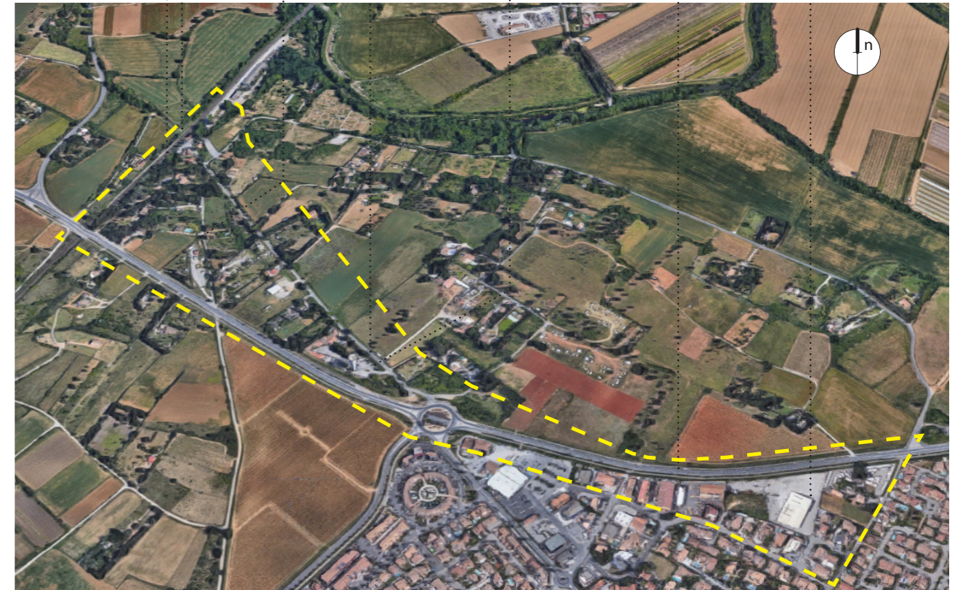
Photo aérienne du secteur d'étude de la gare et son accroche urbaine (source GoogleEarth)
