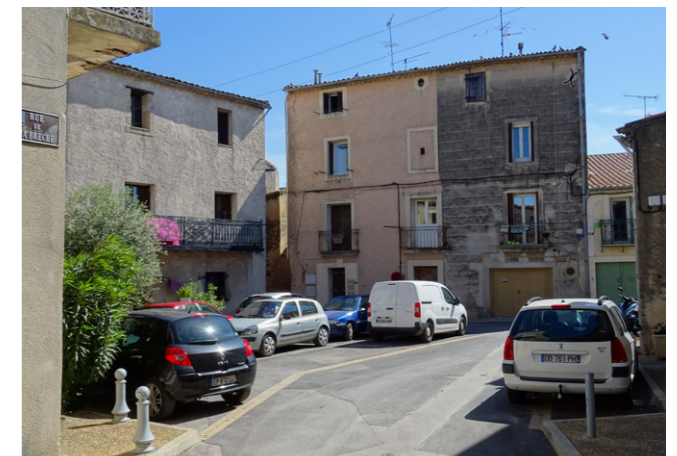
Façades du centre ancien (enduits, percements)
