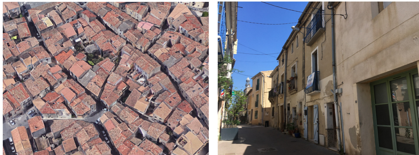
■ Le centre ancien
