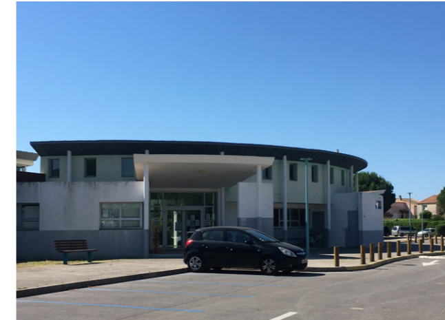
16 Groupe scolaire F. Dolto, entrée
