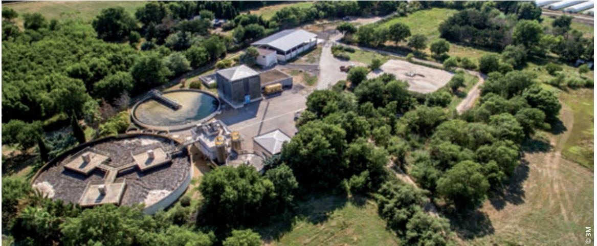
Station d'épuration de Villeneuve-lès-Maguelone
