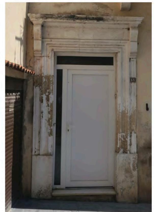
Châssis de porte PVC / alu inadaptée à l'encadrement
