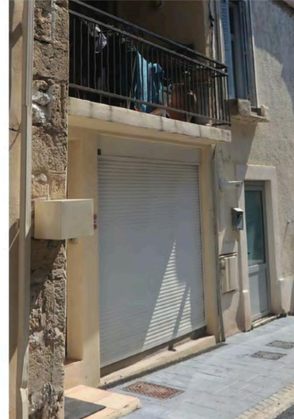
Dispositifs techniques en façade, volet roulant PVC, châssis de porte inadaptée à l'encadrement, BAL en saillance
