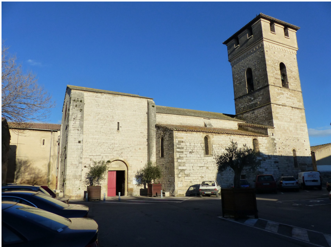
Vue générale depuis la place – Le dégagement des stationnements le long du monument participerait à sa mise en valeur.
