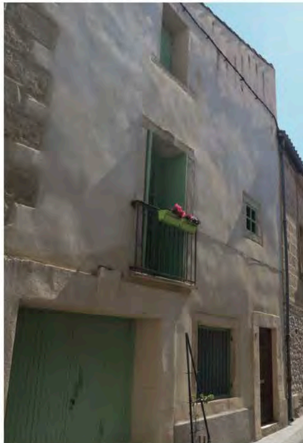
Enduit en sur-épaisseur
