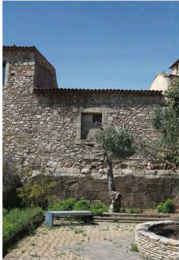
Base de rempart, parement en pierre de taille
