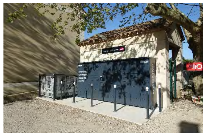
Les équipements de la gare: billetterie, box vélo, retrait colis Amazon, borne de rechargement voiture électrique, arrêt de bus 44
