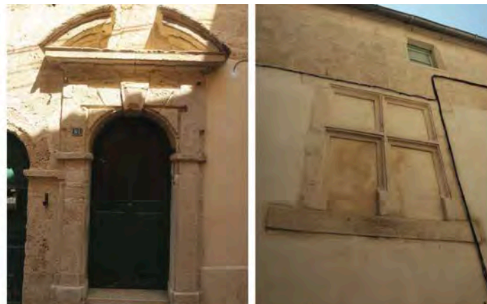
Encadrement de porte à fronton segmentaire avec haut coupé
