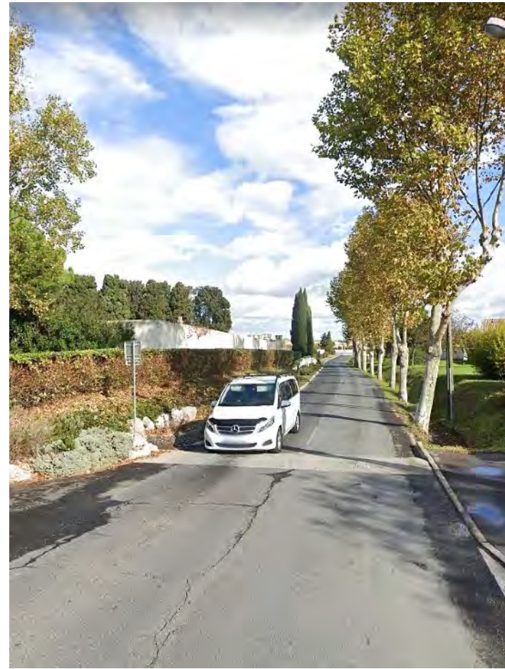
2. Avenue de Palavas le long du cimetière - Démarrage d'une piste cyclable
