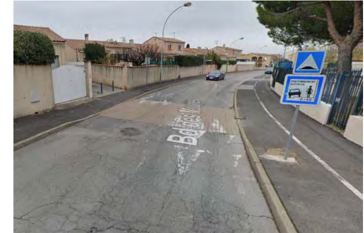
Bd des Moures : des possibilités de stationnement souvent peu utiles, à requestionner en l'absence de liaison cyclable Nord - Sud
