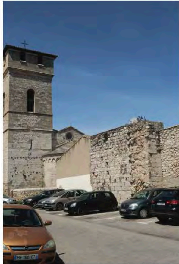
Passage Notre Dame, arrachement de l'ancienne porte
