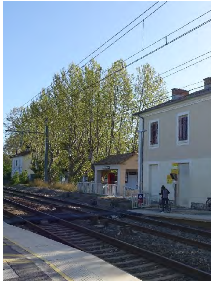
3. La gare et l'ancien bâtiment utilisé par le secours populaire
