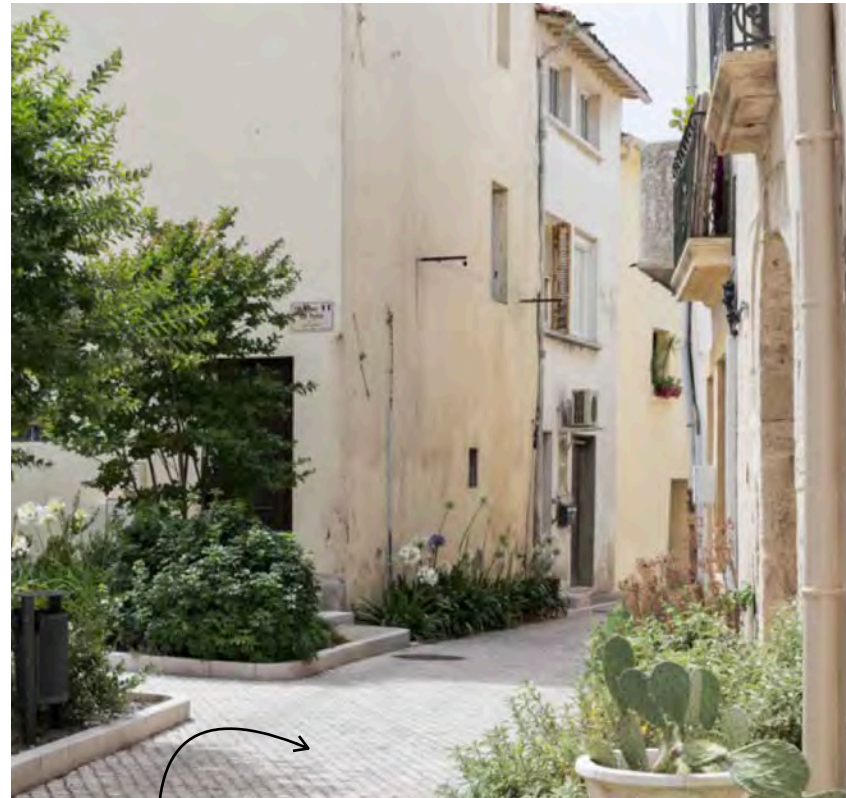
Sol pavé sur l'ensemble du linéaire de la Grand'rue avec fil d'eau central ou latéral Référence : Atelier SITES
