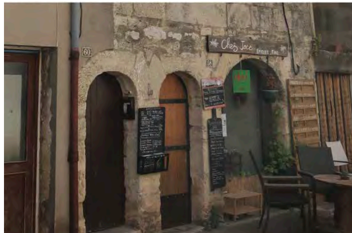
Succession de portes et boutiques à arc en plein cintre, immeuble en pierre de taille
