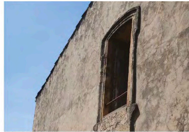
Encadrement de fenêtre à arc surbaissé
