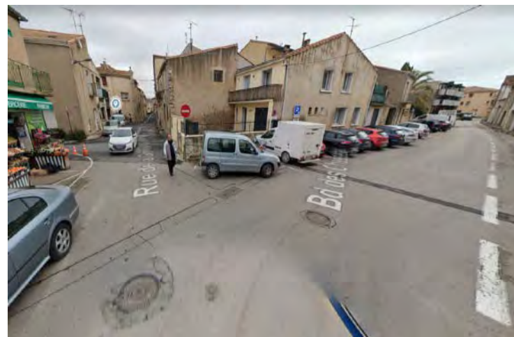
Carrefour Salins / Chasselas / Grenouillère : des besoins de stationnement à maintenir, réglementés, une offre à mieux matérialiser, tenant compte des autres usagers
