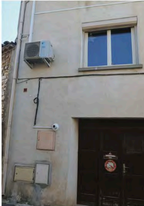
Quinté : Ventouse de ventilation, unité de climatisation, goulottes électriques, bloc de volet roulant, descente EP en PVC
