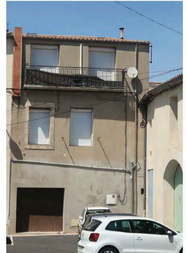
Descentes d'eaux usées en façade
