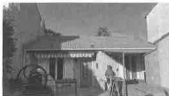
Photo de la construction (DP 5)
