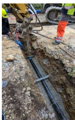
Pose d'un réseau d'eau potable sur la commune de Prades-le-Lez
