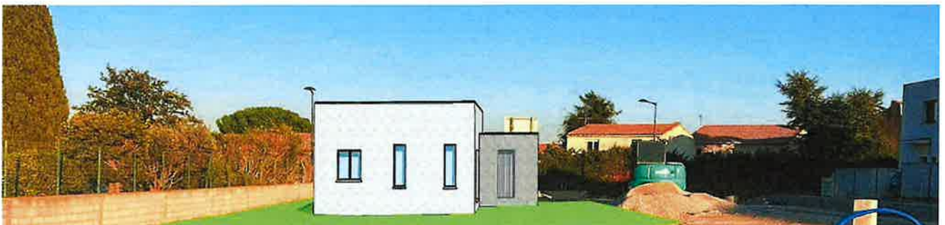
Insertion sur site
