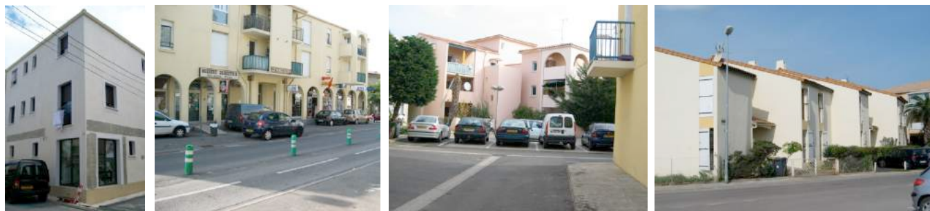
Vues sur des exemples de logements collectifs Source : Synergies
